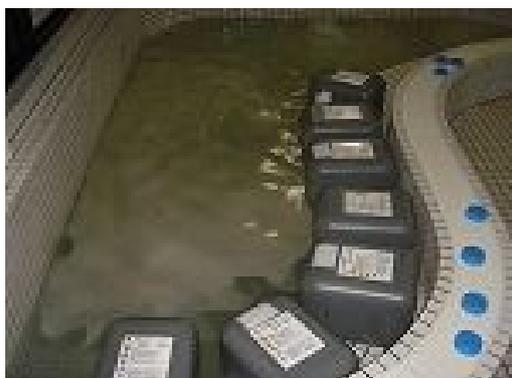
過酸化水素は使用量が多くなるため、循環できる最低レベルまで減水し、投入します。
